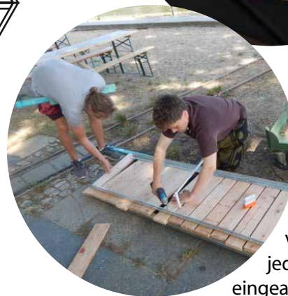
Auch ein Steg kann mit Lochschienen und Dielen einfach und stabil gefertigt werden. Um eine Verscherung zu verhindern, müssen jedoch auch Diagonalen eingearbeitet werden.
